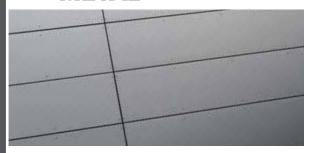
Bardage métallique en façade de type acier galvanisé prélaqué, un gage de durabilité.
